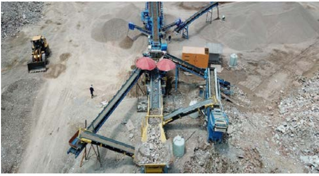
Рис. 2. Дробильно-сортувальний комплекс фірми «GER ECOTECH»
